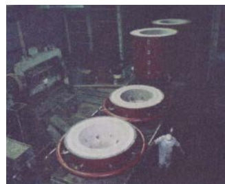
電力發電用耐火爐 內部 貼有耐火磚
